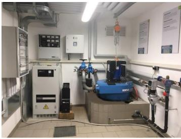
プレドイ地域の水量変動(春から秋:8kW 冬:最低3kW)を考慮し、水力発電システムの最大生産量は、アルプスの山荘に電力を安定的に供給するために作られました。
